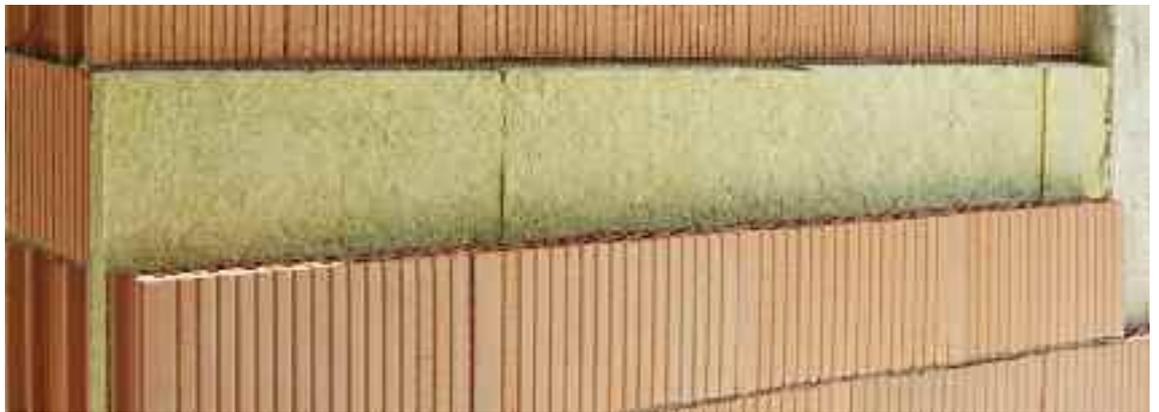
L'incremento delle prestazioni termiche di pareti portanti in laterizio o di setti in calcestruzzo armato può essere ottenuto accoppiando a tali elementi strutturali uno strato di materiale isolante ed un tavolato realizzato con tramezze **POROTON® P800** o
